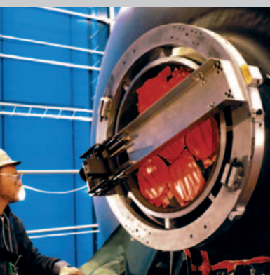
Как опция "перекидной мостик" для толстостенных труб. Разделка кромок.
